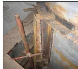
Slika 10. Sanirana struktura dimnjaka
